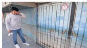
Néstor y su familia abandonaron desde agosto su casa, ubicada en el punto más afectado por la inundación.
