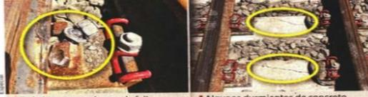
En la imagen se observa la falta de sujetadores en los rieles. Algunos durmientes de concreto se observan fracturados.
