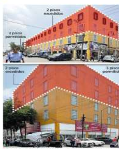
Dos inmuebles de la calle Joaquín Herrera, alrededores al Barrio de Tepito, fueron construidos con pisos adicionales a los permitidos por la ley.
