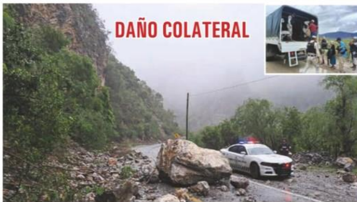
Aunque varias presas en el norte del país empezaron a recuperar sus reservas acuíferas, en Nuevo León, Tamaulipas y Veracruz se reciente el "daño colateral de los aguaceros", como deslaves en carreteras e inundaciones en poblados. (Fotos: Cuartoscuro) ▶ 18
