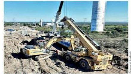
DUCTO SIN UNIR. Zanjas y tubería sin unir se capturaron sobre el trayecto del acueducto a la altura de la Planta de Bombeo No. 2, en Los Ramones.
