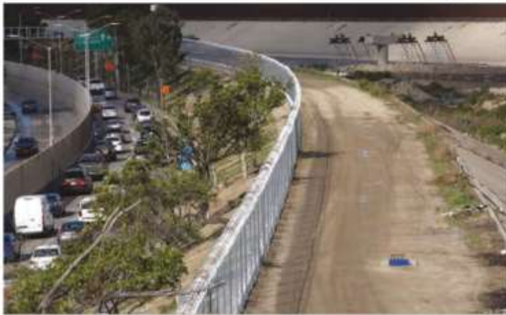
Autoridades mexicanas instalaron recientemente un muro fronterizo con malla ciclónica a lo largo del río Tijuana para desalentar el cruce de migrantes hacia Estados Unidos. (Foto: Cortesía de The San Diego Union-Tribune)
